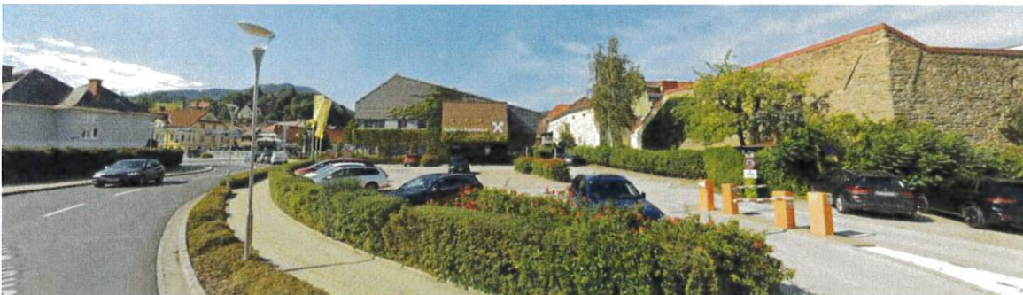
Abbildung 10: Ansicht aus Südost mit Planungsgebiet und denkmalgeschützter Stadtmauer (Quelle: google street view)
